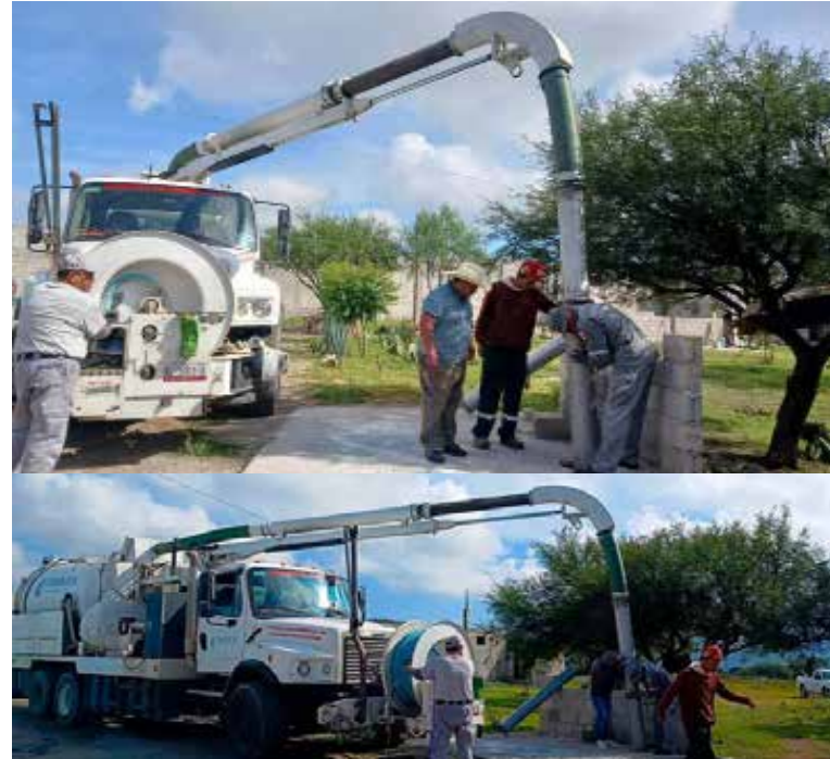
Estas labores tienen como objetivo principal, el de prevenir taponamientos que puedan generar inundaciones ante las lluvias registradas
