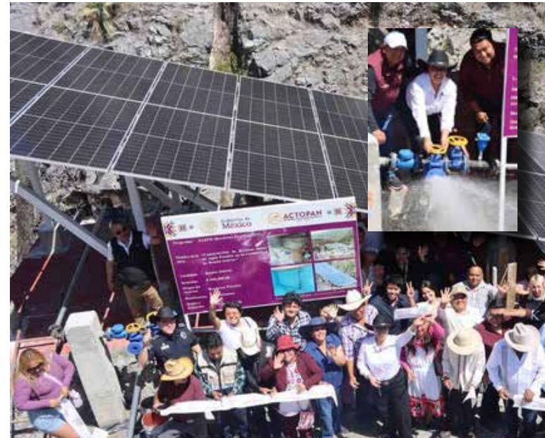
La presidenta municipal Imelda Cuéllar Cano inauguró la obra de bombeo solar de agua, que llevará el vital líquido a la comunidad de Benito Juárez
