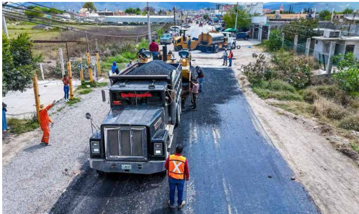
Inicio de trabajos de reencarpetamiento asfáltico en la avenida Lázaro Cárdenas
