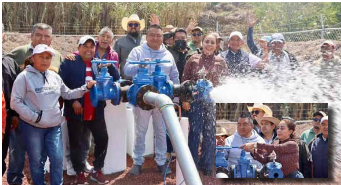
La obra permitirá mejorar el abastecimiento de agua para diversas familias de esta comunidad
