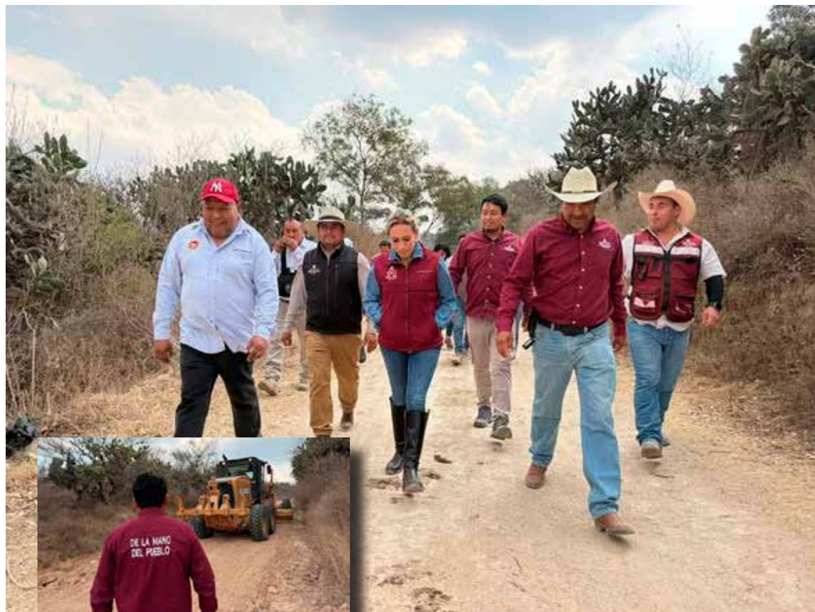
Las labores se realizan en la calle Extensión Puerta Blanca, donde se lleva a cabo el acondicionamiento de un camino con más de 1.6 kilómetros
