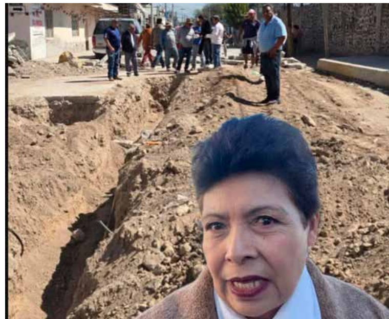
La obra presenta problemas, al realizar pruebas ahora al verter líquidos no salían por ningún lado por lo que fue necesario levantar la tubería para revisar la situación.
