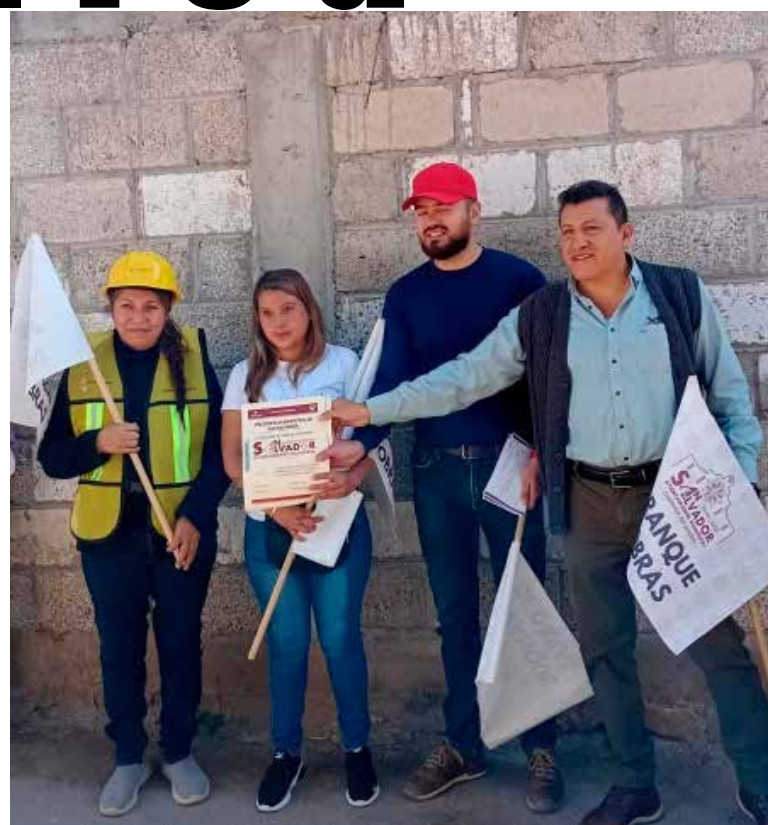
Trabajos de pavimentación hidráulica en la calle 1° de Mayo
