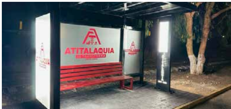
Instalación de una estructura adecuada para la parada de transporte público en la zona conocida como del “Puente de Bojay”
