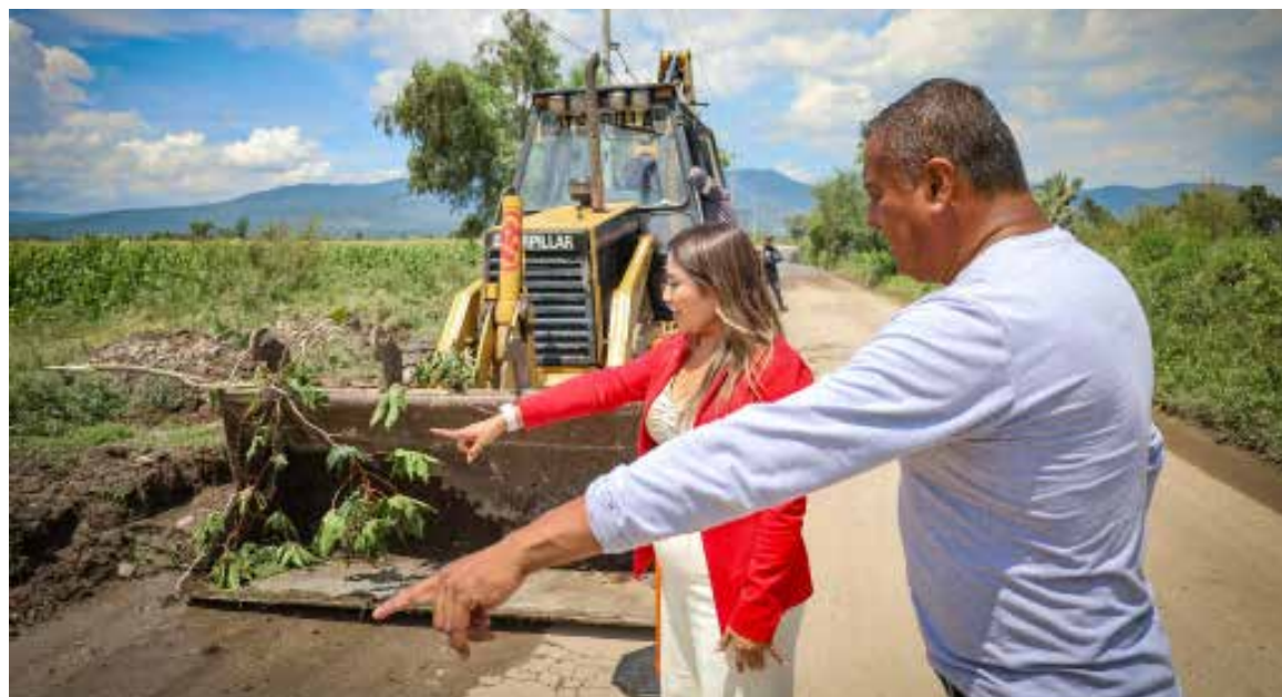
Las autoridades municipales ya están trabajando en colaboración con diferentes dependencias para agilizar las reparaciones
