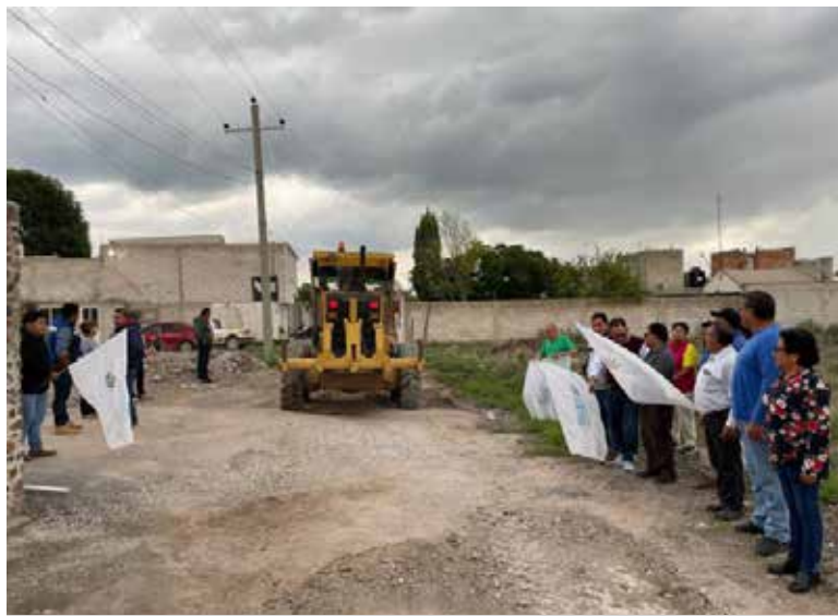
Presidente municipal Ricardo Josué Olguín Pardo, dio inicio a los trabajos de pavimentación asfáltica
