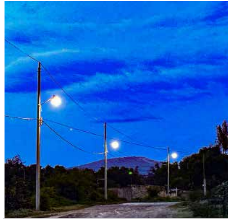
La Dirección de Servicios Públicos contribuyó al proyecto con la instalación de 10 lámparas de alumbrado público.
